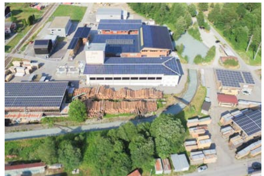
Areal der Tarcisi Maissen SA mit den Photovoltaik-Dächern auf den Produktionshallen.
